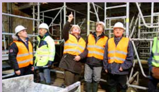
Le Maire, Christophe Paquis et Claude Ermogeni, Maire-adjoints, au fond du puits principal de la station Mairie des Lilas.
