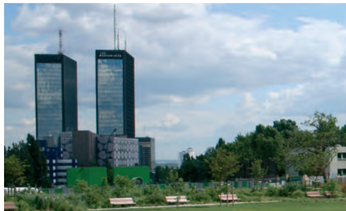
Les tours Mercuriales à Bagnole où sont installés les émetteurs qui perturbent la réception de stations radio de la bande FM.
