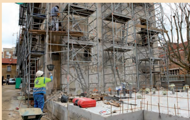
Rénovation du LEP Romain-Rolland.
