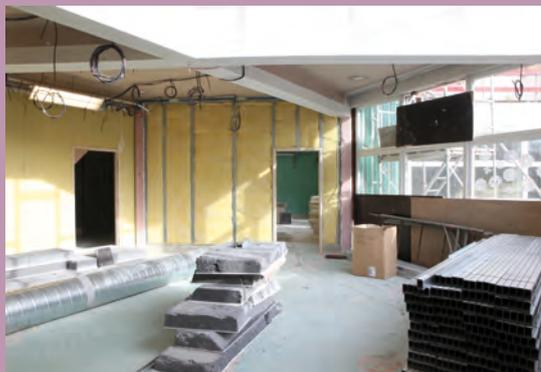
Le chantier de la maternelle avance. Les cloisons intérieures, les réseaux électriques et l'isolation des murs sont pratiquement achevés. Les gaines de ventilation sont posées.
