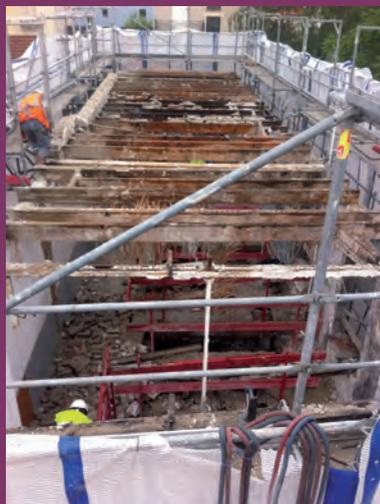
Dernier coup de pioche pour la première partie de la démolition de l'îlot I de la ZAC. L'hôtel situé au fond de la parcelle a dû être démolé « manuellement », c'est-à-dire au marteau piqueur par les ouvriers, étage par étage. Vu la configuration des lieux, il était en effet impossible d'utiliser les pelleteuses habituelles.
