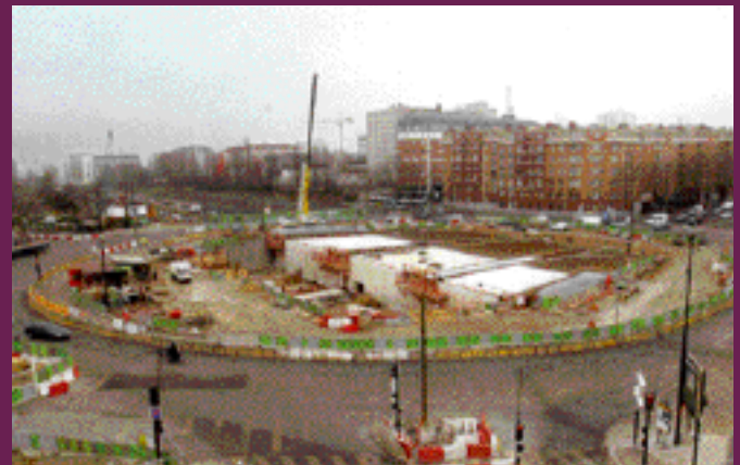
Le chantier actuel.
