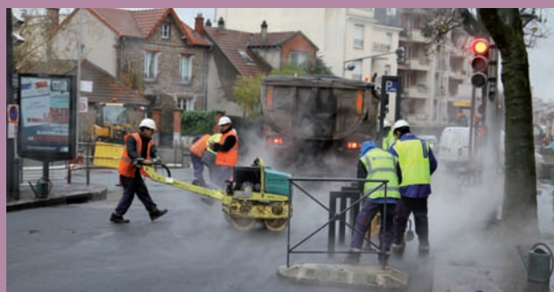
Travaux avenue des combattants d'Afrique du nord.
