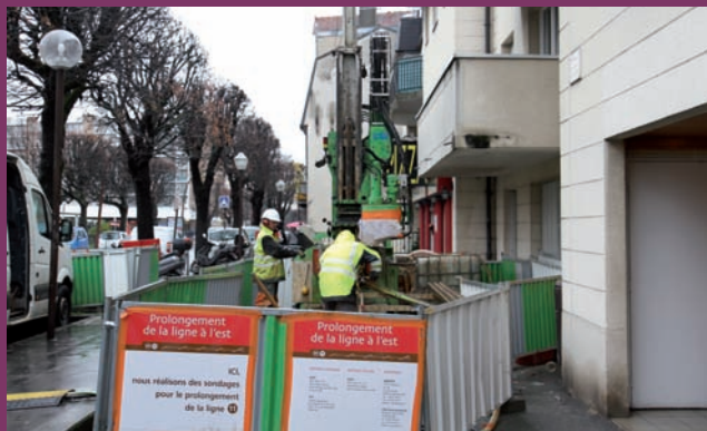
Forage à 65 mètres de profondeur boulevard de la Liberté, près de la sente Giraud.
