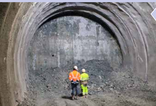
Le percement du tunnel entre les stations Mairie des Lilas et Serge-Gainsbourg est terminé.
