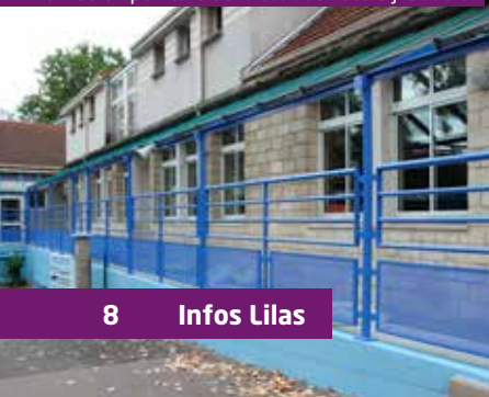
Remise en peinture de la cour de l'école J. Daubié
