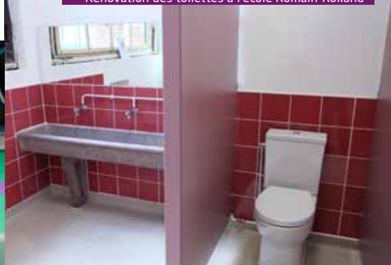
Rénovation des toilettes à l'école Romain-Rolland
